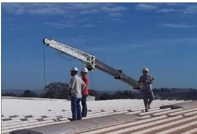
Figura 24 – Jib de 9,5m. montado com ângulo de 0°.
