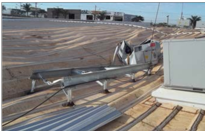
Figura 22 – Destruição parcial da cobertura metálica.
